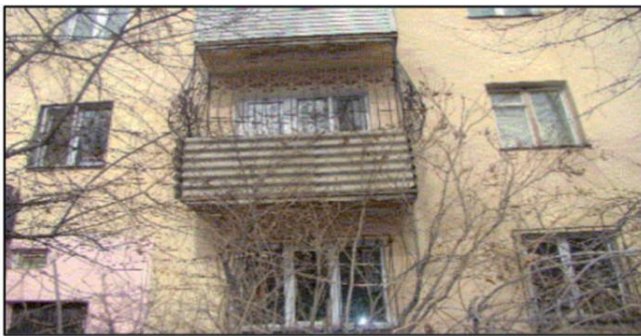
А. Орон сууцны тагтыг асбестан хавтангаар доторлосон байдал
