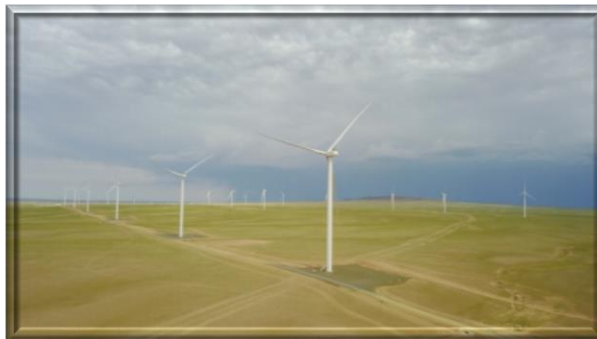
2017 50 МВт (Цэций) Салхины станц Өмнөговь
