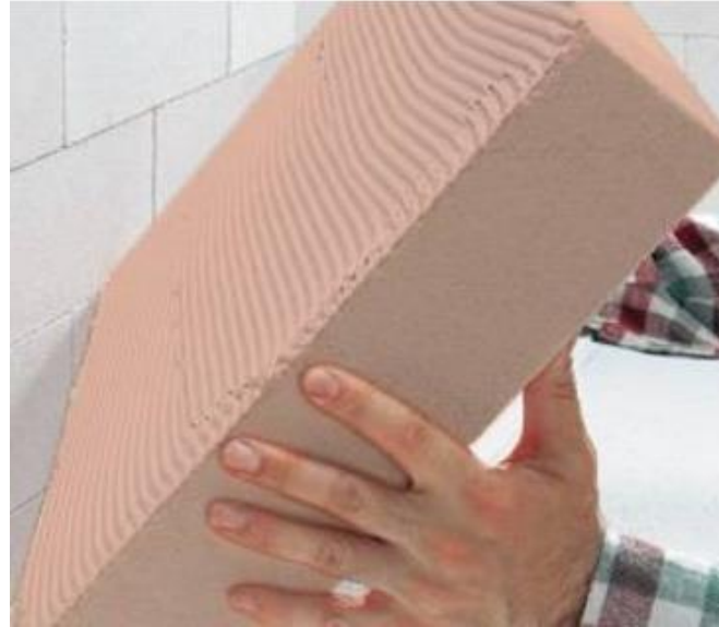
Диффузэд орох эрдэс хөөсөнцөр-хавтан, чийгийг шингээнэ, \lambda = 0,045 \text{ Вт/м}^2\text{К}
